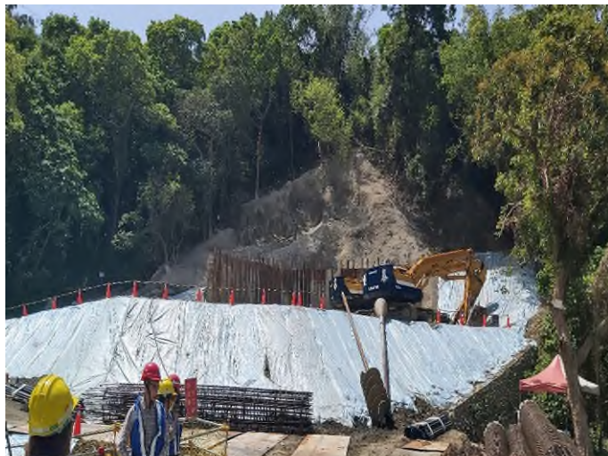
未來施作繫梁擋土牆、自由型格梁框位置
