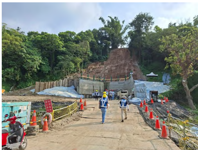
施作自由型格梁框位置
