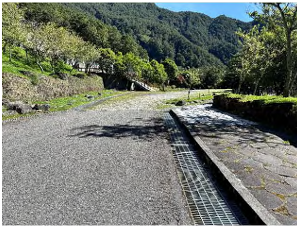
遊客中心區滯洪沉砂池預定位置及 既有排水
